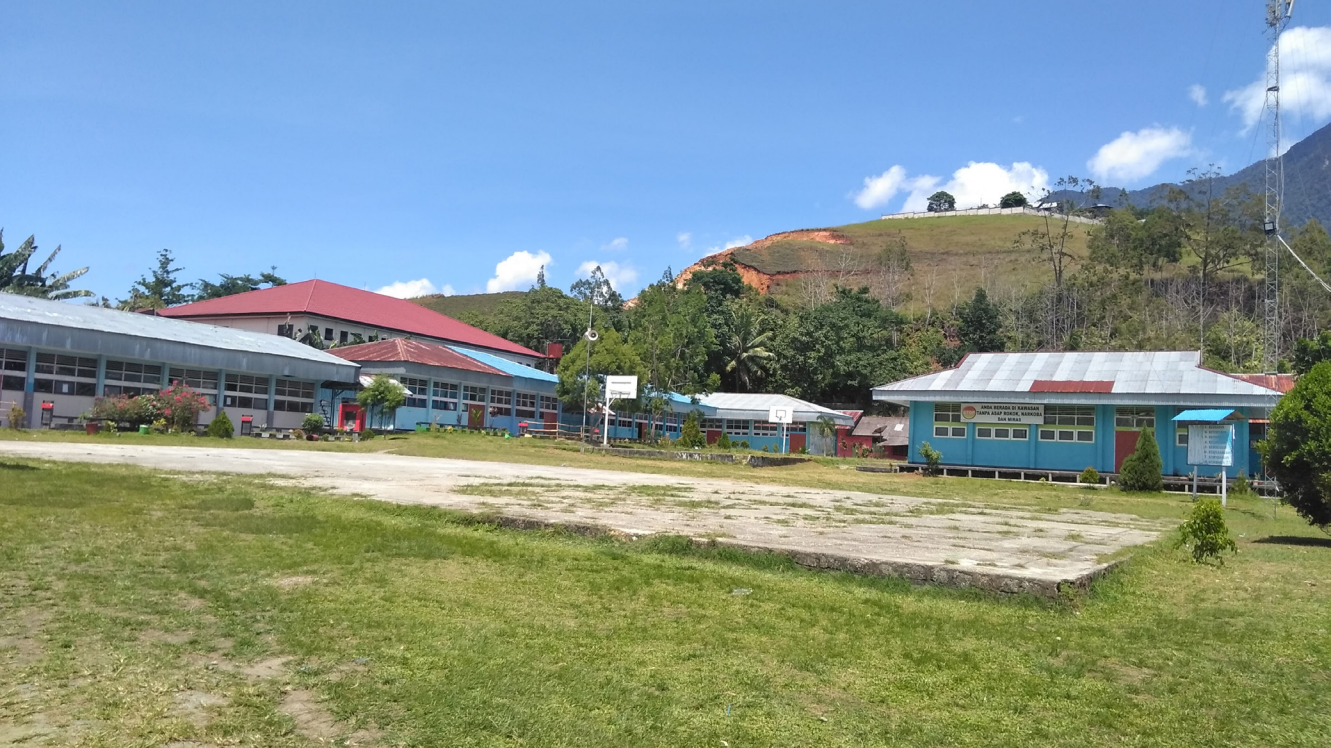
Bangunan SMAN 1 Sentani, Papua dengan latar belakang bukit (kiri & kanan).
